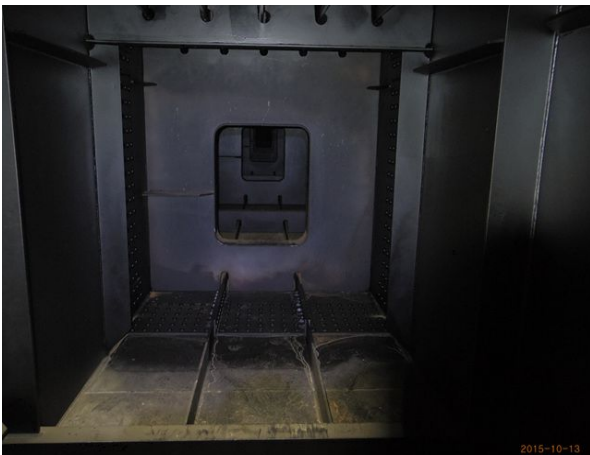
거더 내부 전경
