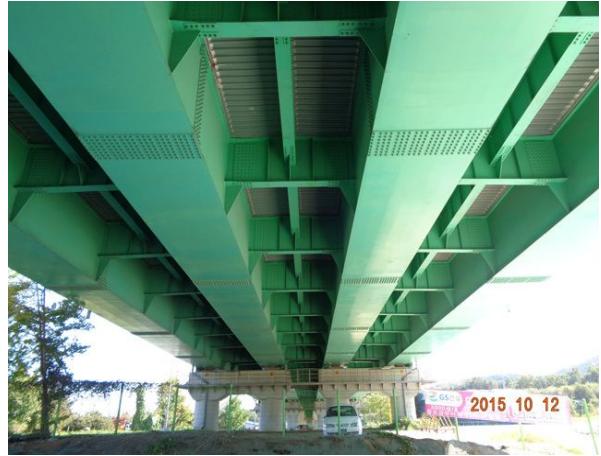
바닥판 및 거더 전경
